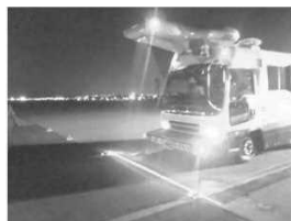
(基本施設点検実施状況)
