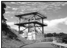
遠隔対空通信施設
