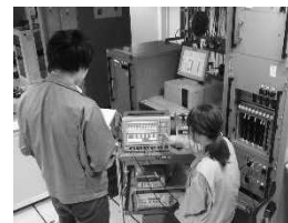
(航空保安施設点検実施状況)
